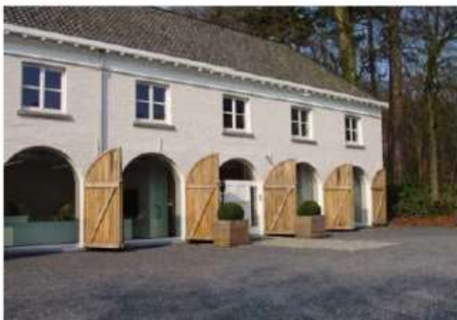
nl. 22 Het koetsgebouw met zijn indrukwekkende inrijpoorten na de geslaagde restauratie
